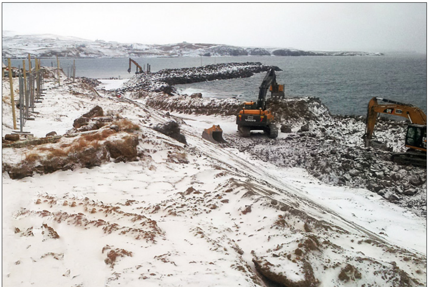
Framkvæmdir við hafnabætur á Húsavík 12. janúar 2016.
