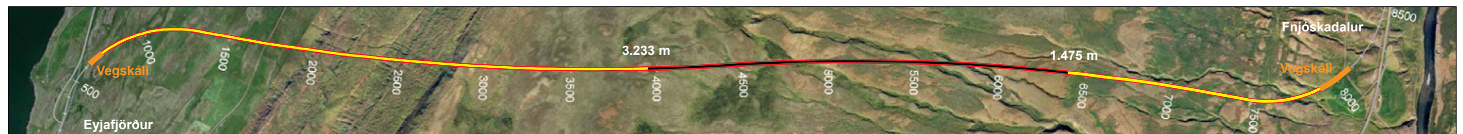
Vaðlaheiðargöng, staða framkvæmda 25. janúar 2016. Búið er að sprengja samtals 4.708 m sem er 65 % af heildarlengd.
